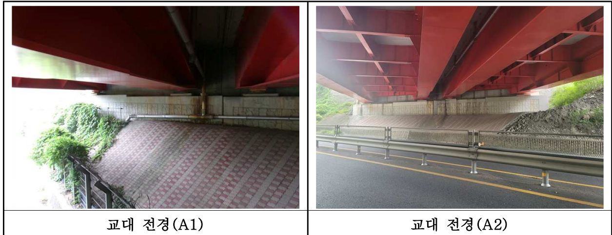
【사진 27.3.8】 교대 전경
