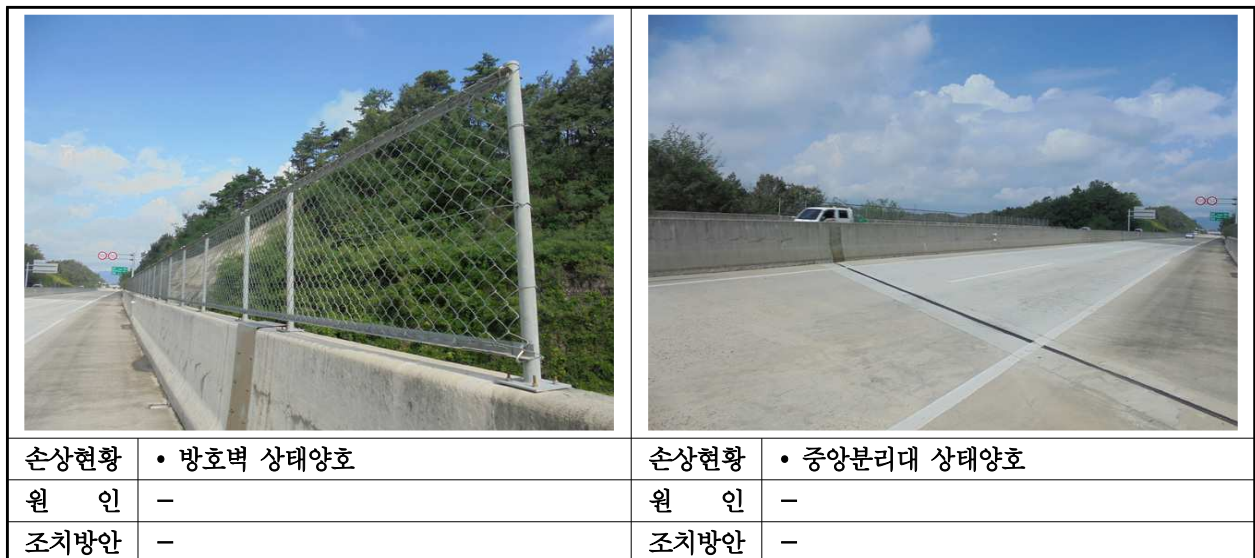
【사진 27.3.22】 방호벽 및 중앙분리대 외관조사 결과
