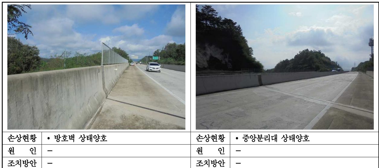
【사진 27.3.45】 방호벽 및 중앙분리대 외관조사 결과
