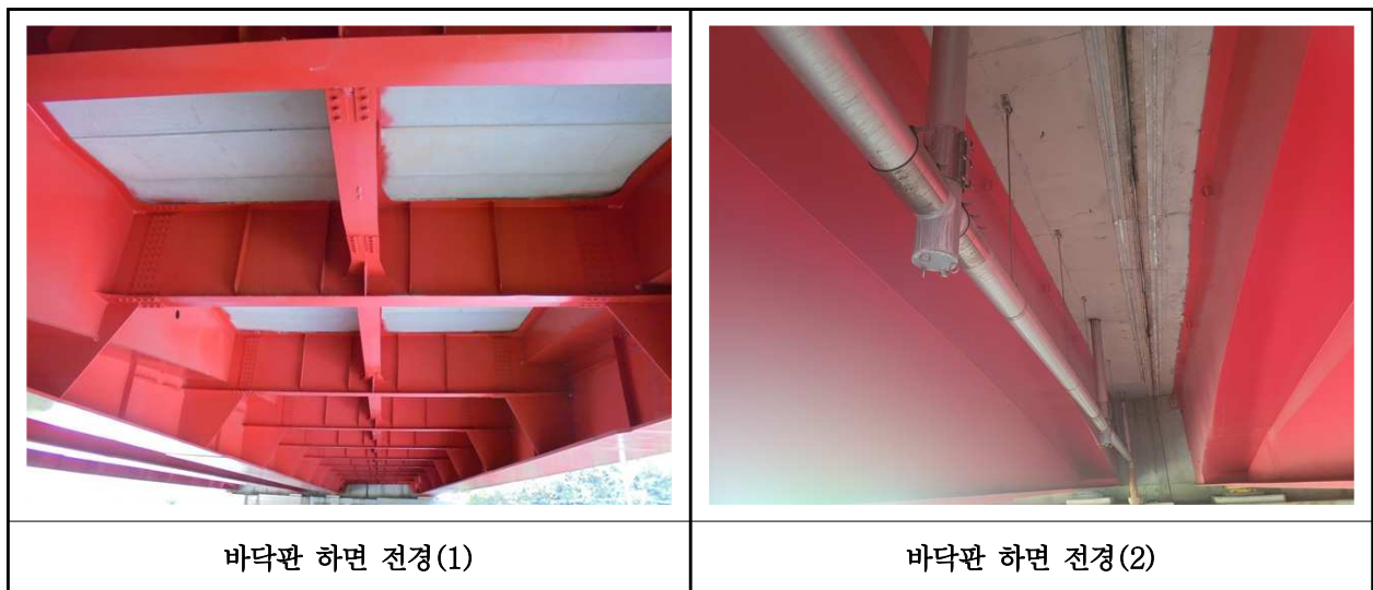
【사진 27.3.25】 바닥판하면 전경
