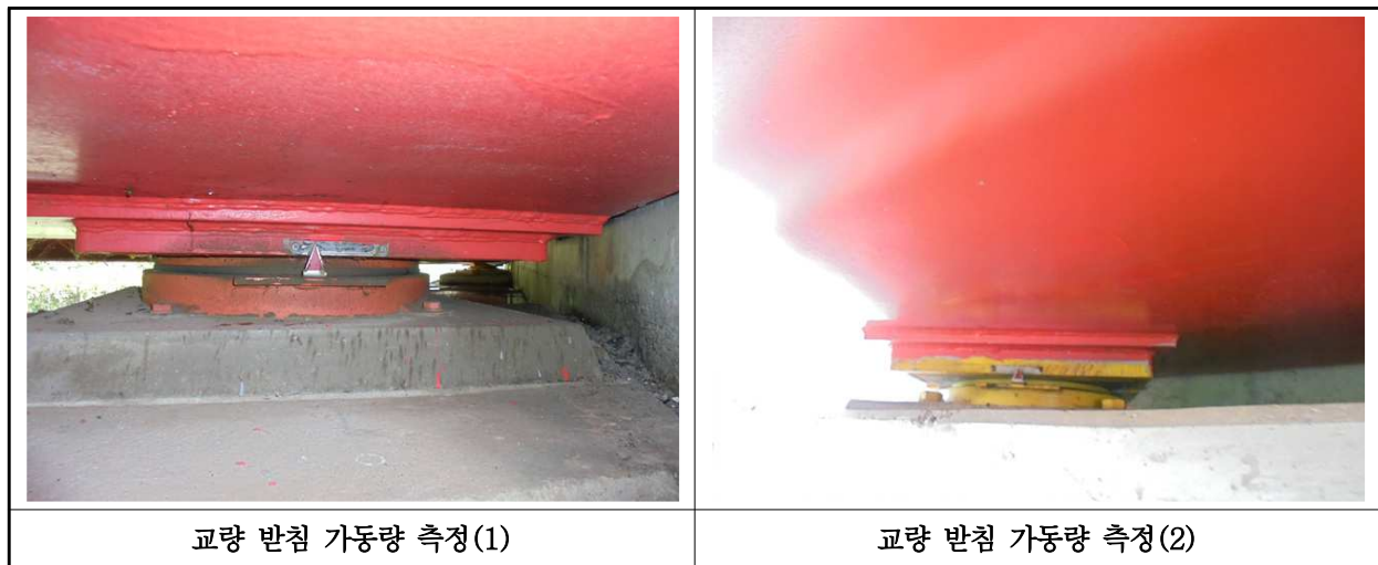
【사진 27.3.36】 교량받침 이동량 측정
