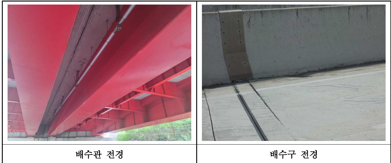
【사진 27.3.42】 배수시설 전경
