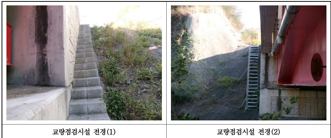
【사진 27.3.23】 교량 점검시설 전경
