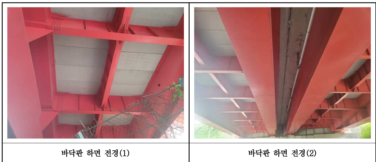
【사진 27.3.2】 바닥판하면 전경
