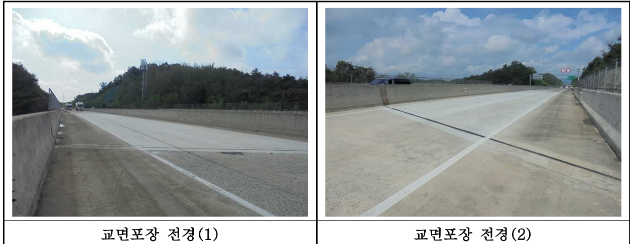
【사진 27.3.17】 교면포장 전경
