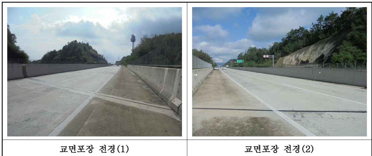
【사진 27.3.40】 교면포장 전경
