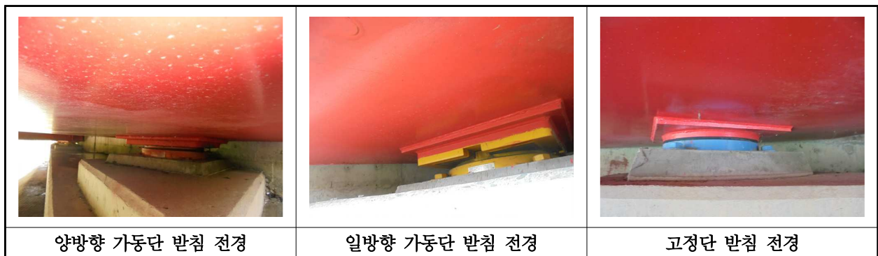
【사진 27.3.33】 교량받침 전경
