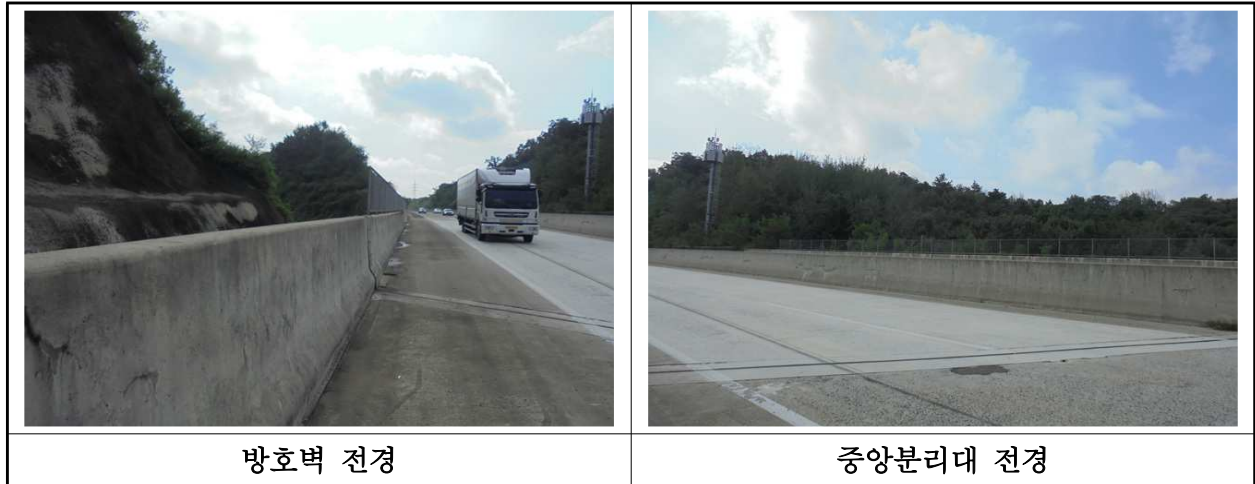
【사진 27.3.21】 방호벽 및 중앙분리대 전경
