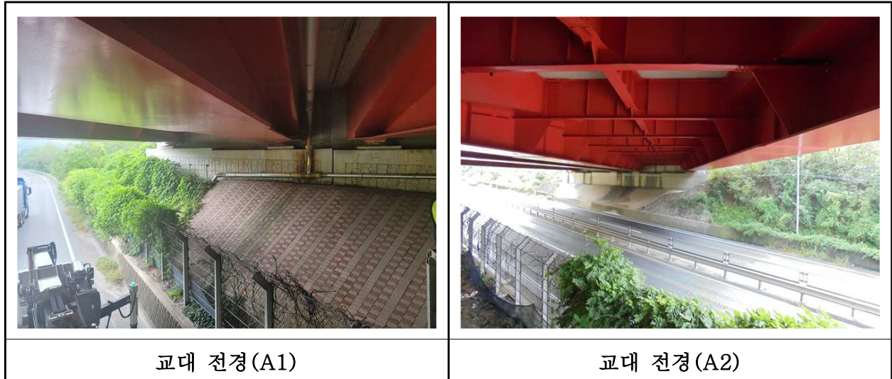
【사진 27.3.31】 교대 전경
