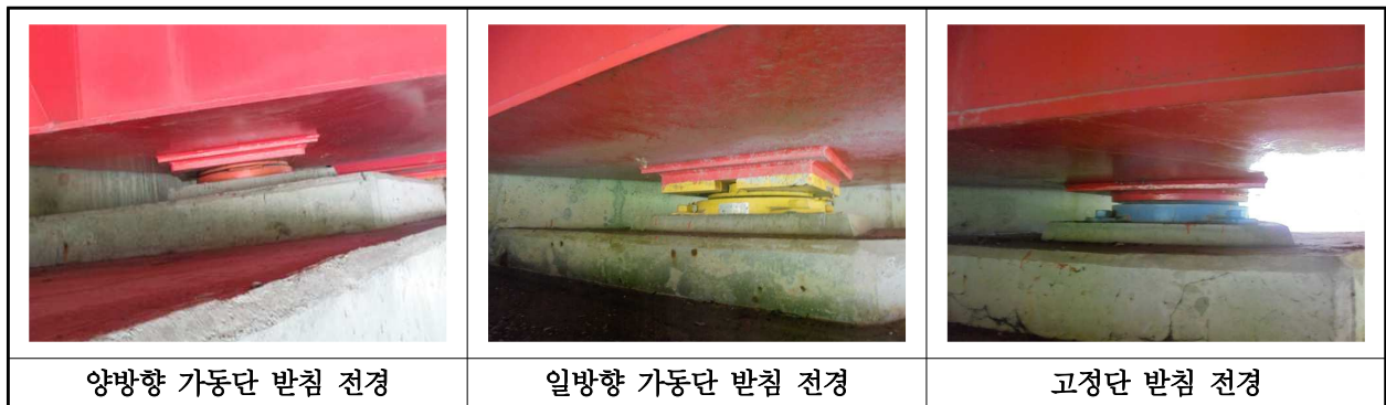
【사진 27.3.10】 교량받침 전경
