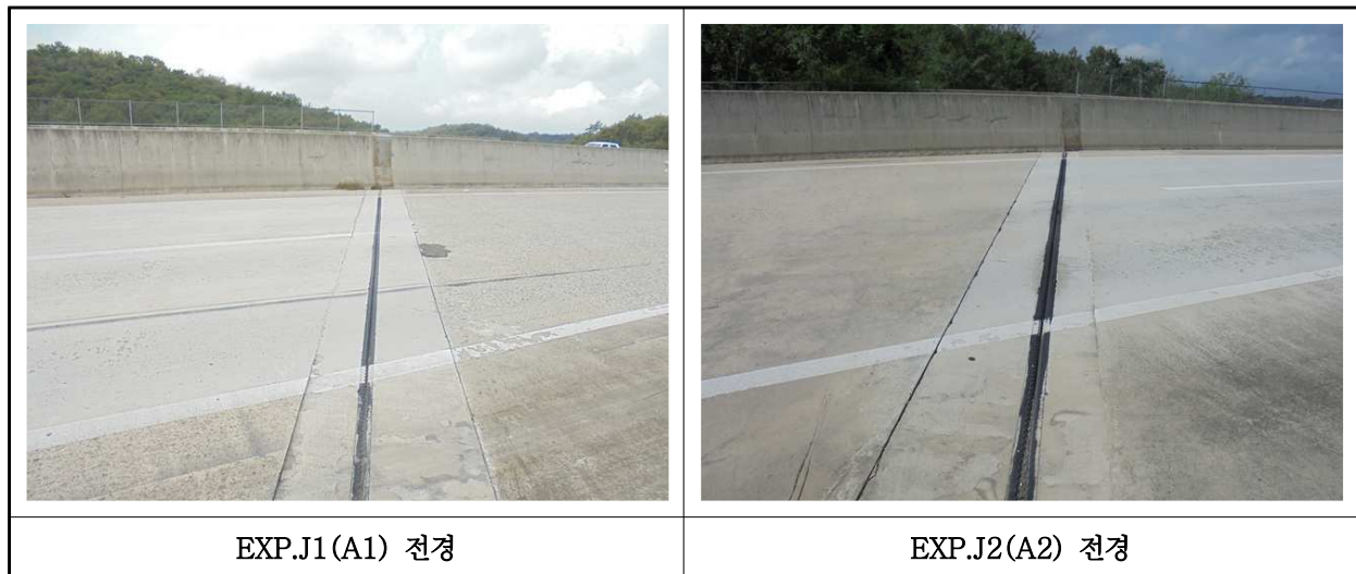
【사진 27.3.14】 신축이음장치 전경
