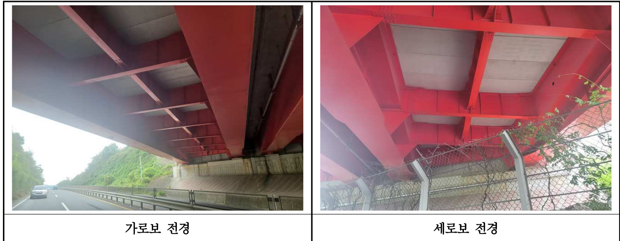
【사진 27.3.6】 가로보 및 세로보 전경
