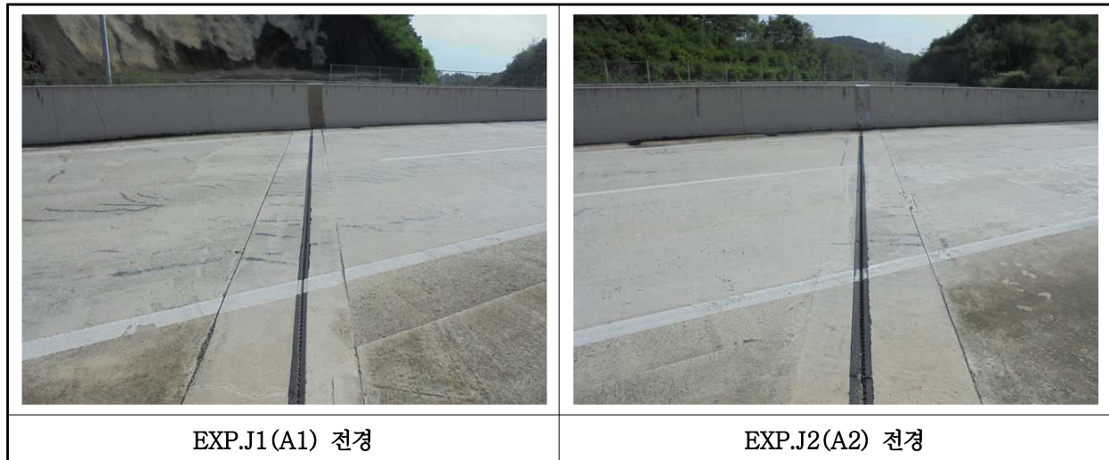
【사진 27.3.37】 신축이음장치 전경
