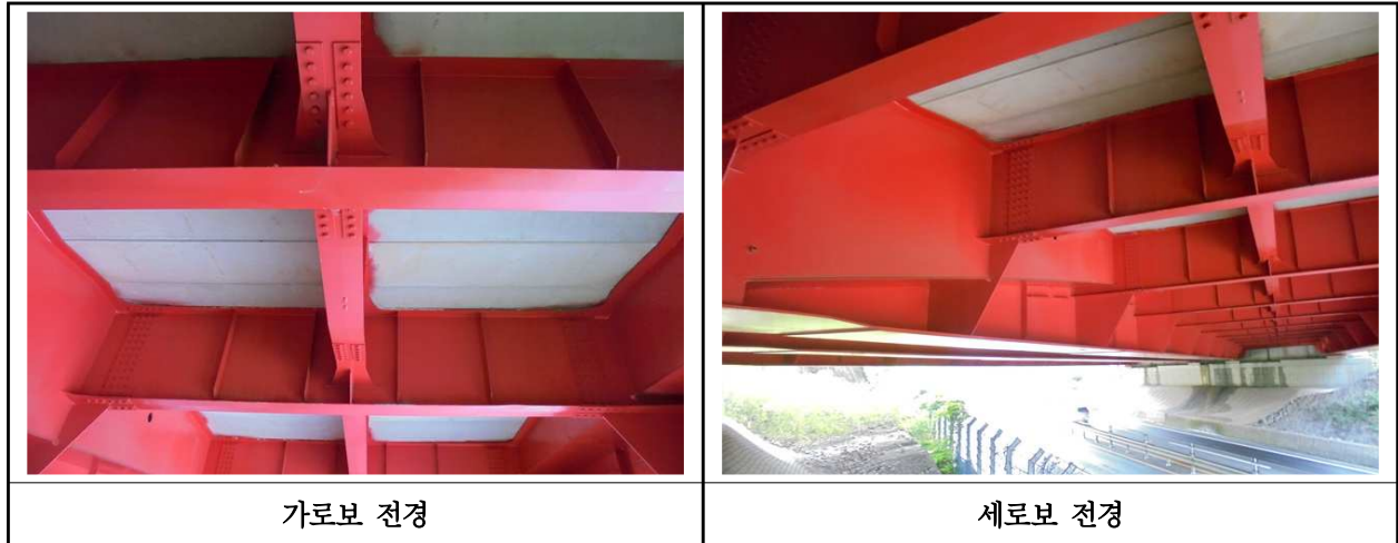
【사진 27.3.29】 가로보 및 세로보 전경
