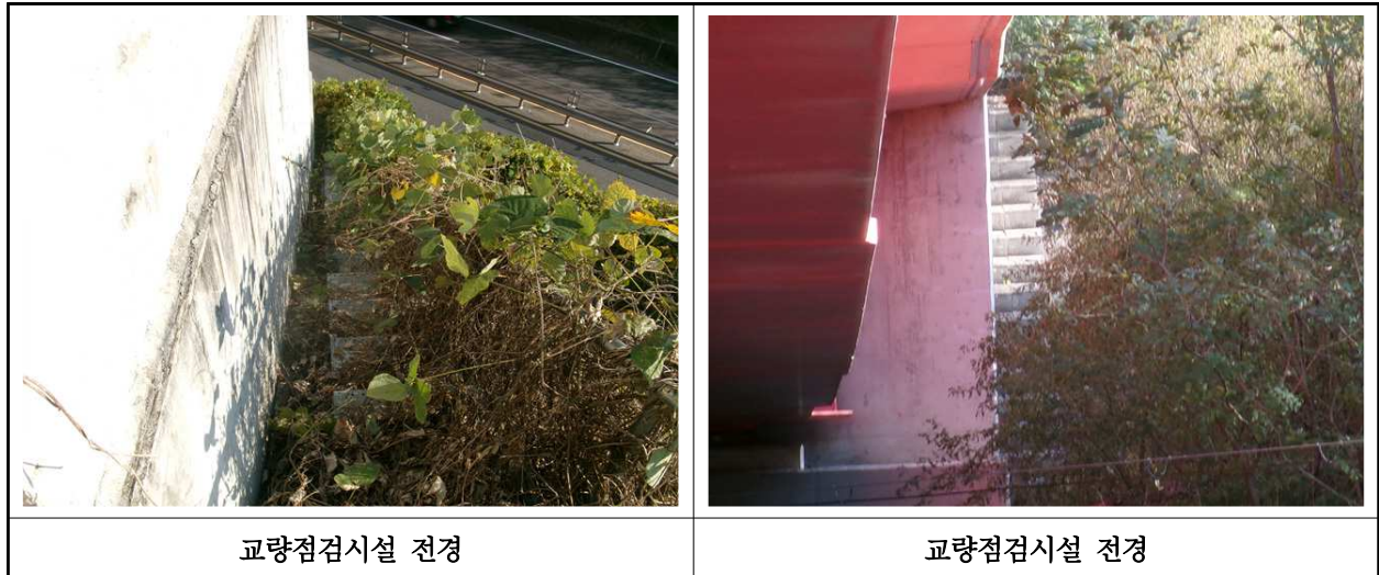
【사진 27.3.47】 교량 점검시설 전경
